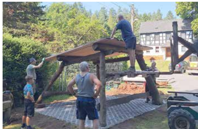
Instandsetzung der Überdachung der „Pilgerhütte“
