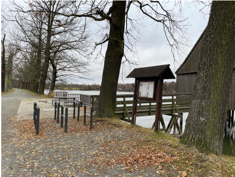
Abb. 14: Historisches Pfahlhaus mit Auslaufbauwerk
